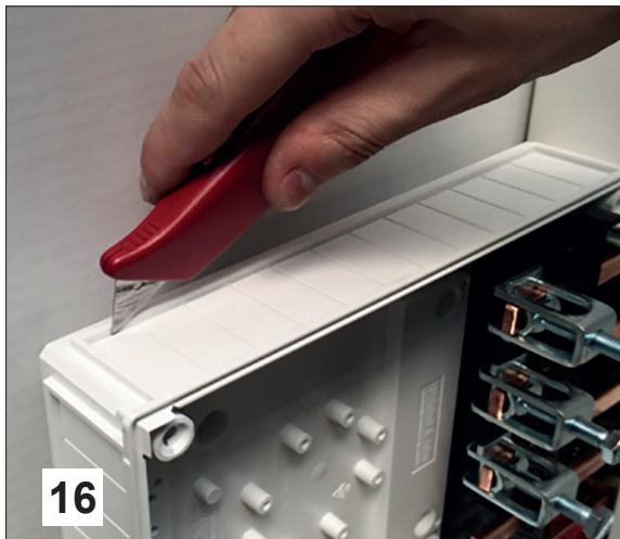
16 Einführung mit Kabel einschwenken und anschließen
