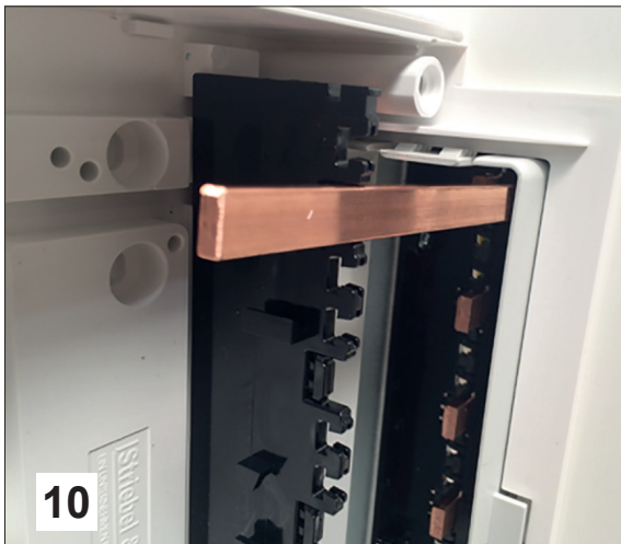
10 CU Schienen einlegen
