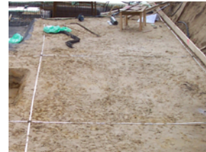
Vermaschter Ringerder unter der Bodenplatte eingebracht
